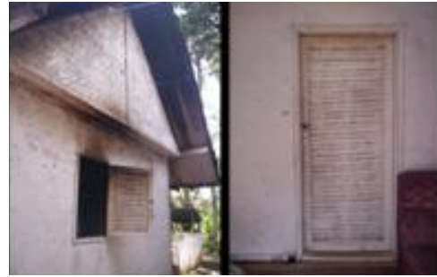
Gambar 12: Pintu, jendela, dan dinding yang terbuat dari anyaman bambu
