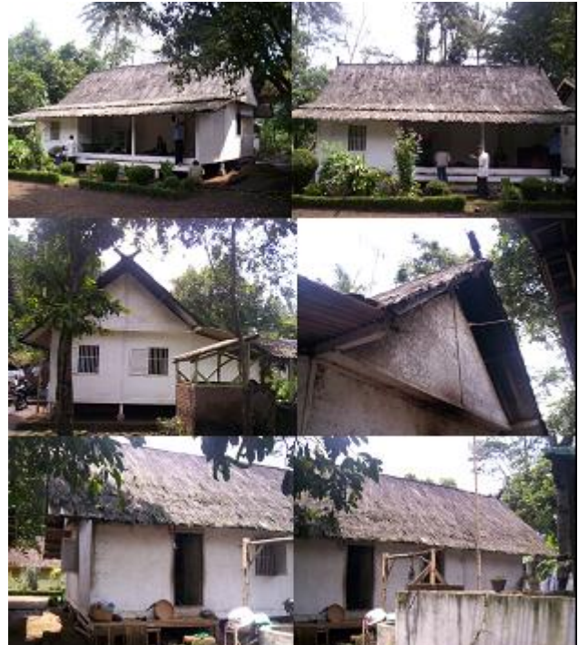
Gambar 8: Bangunan Tradisional Sunda di Kampung Pulo
