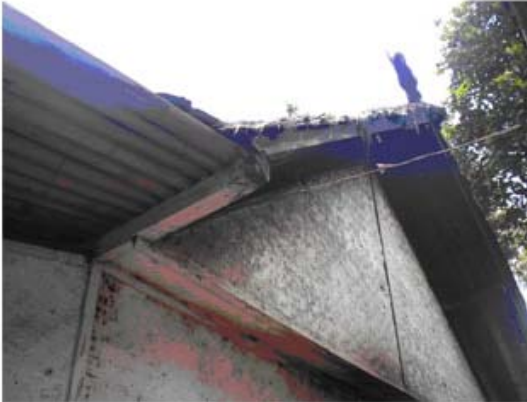
Gambar 10: Bidang atap yang terbuat dari anyaman bambu (gedek)
