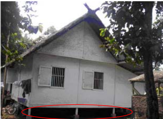
Gambar 11: Lantai panggung pada bangunan tradisional Rumah Kampung Pulo
